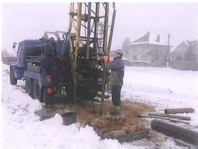
Foto č. 5: Hloubení průzkumné geologické sondy GS-3.
