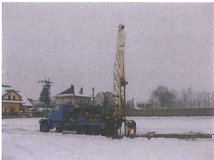
Foto č. 4: Hloubení průzkumné geologické sondy GS-3.
