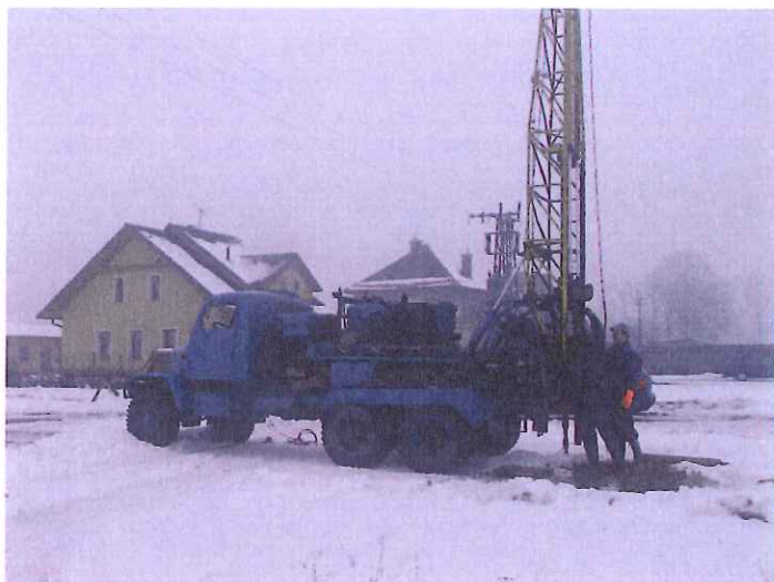
Foto č. 7: Hloubení průzkumné geologické sondy GS-4.
