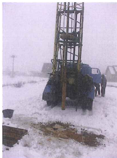
Foto č. 2: Hloubení průzkumné geologické sondy GS-2.
