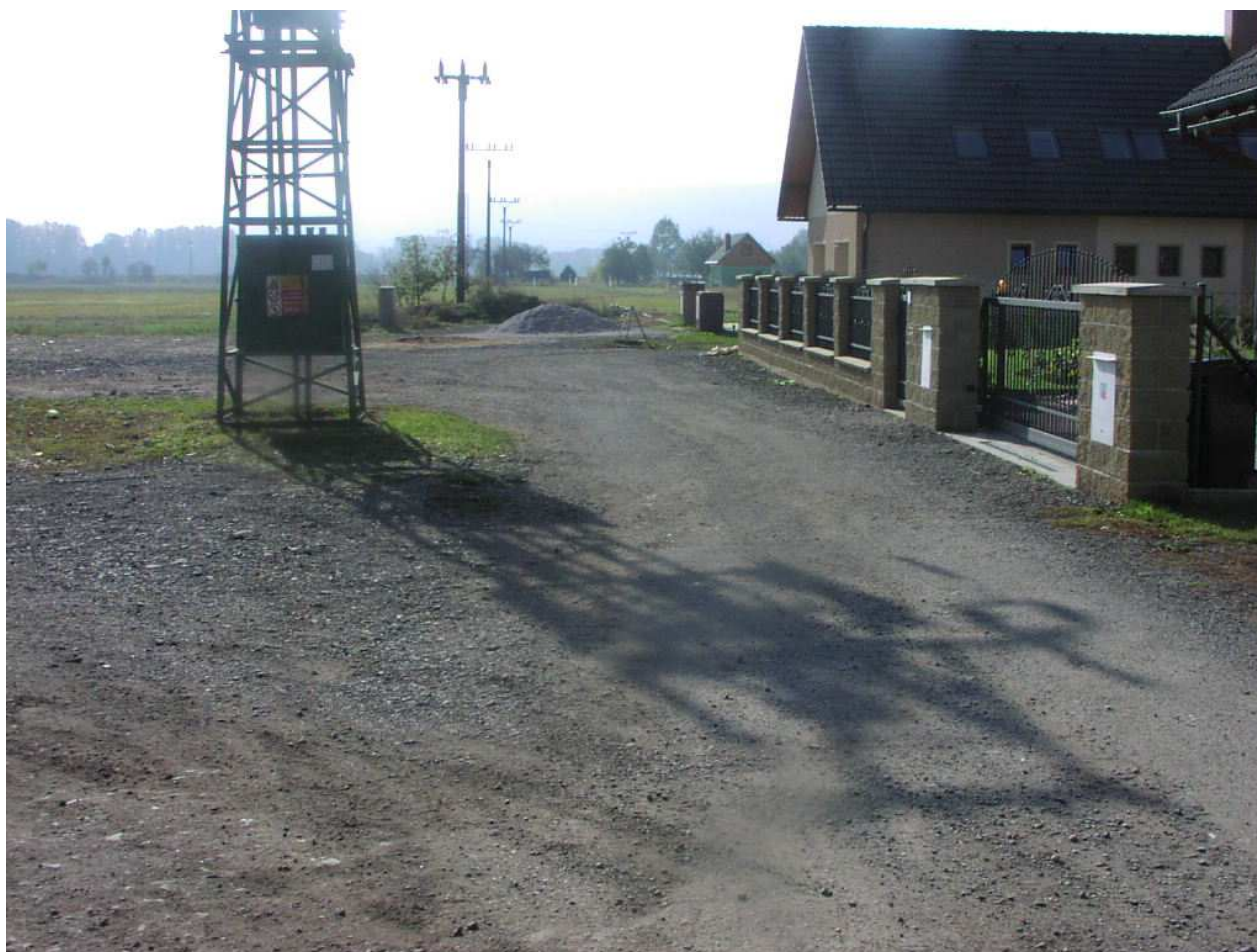
Obr. 4: Vozovka Vachkovy ulice, povrch z recyklovaného asfaltu, vlevo trafo, které je nutno zachovat.
