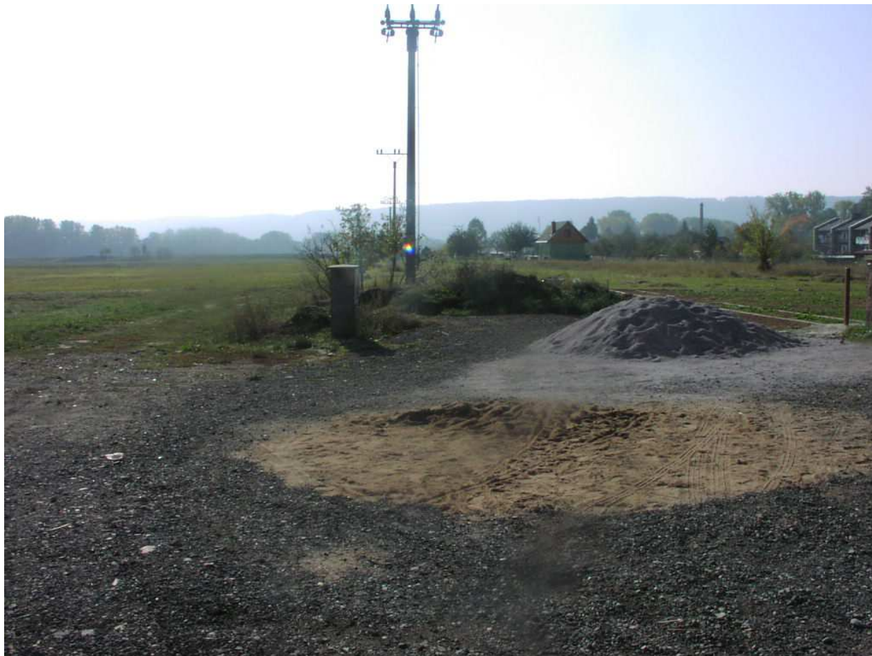
Obr. 7: Vozovka Vachkovy ulice, povrch z recyklovaného asfaltu, konec úpravy, konec zástavby.
