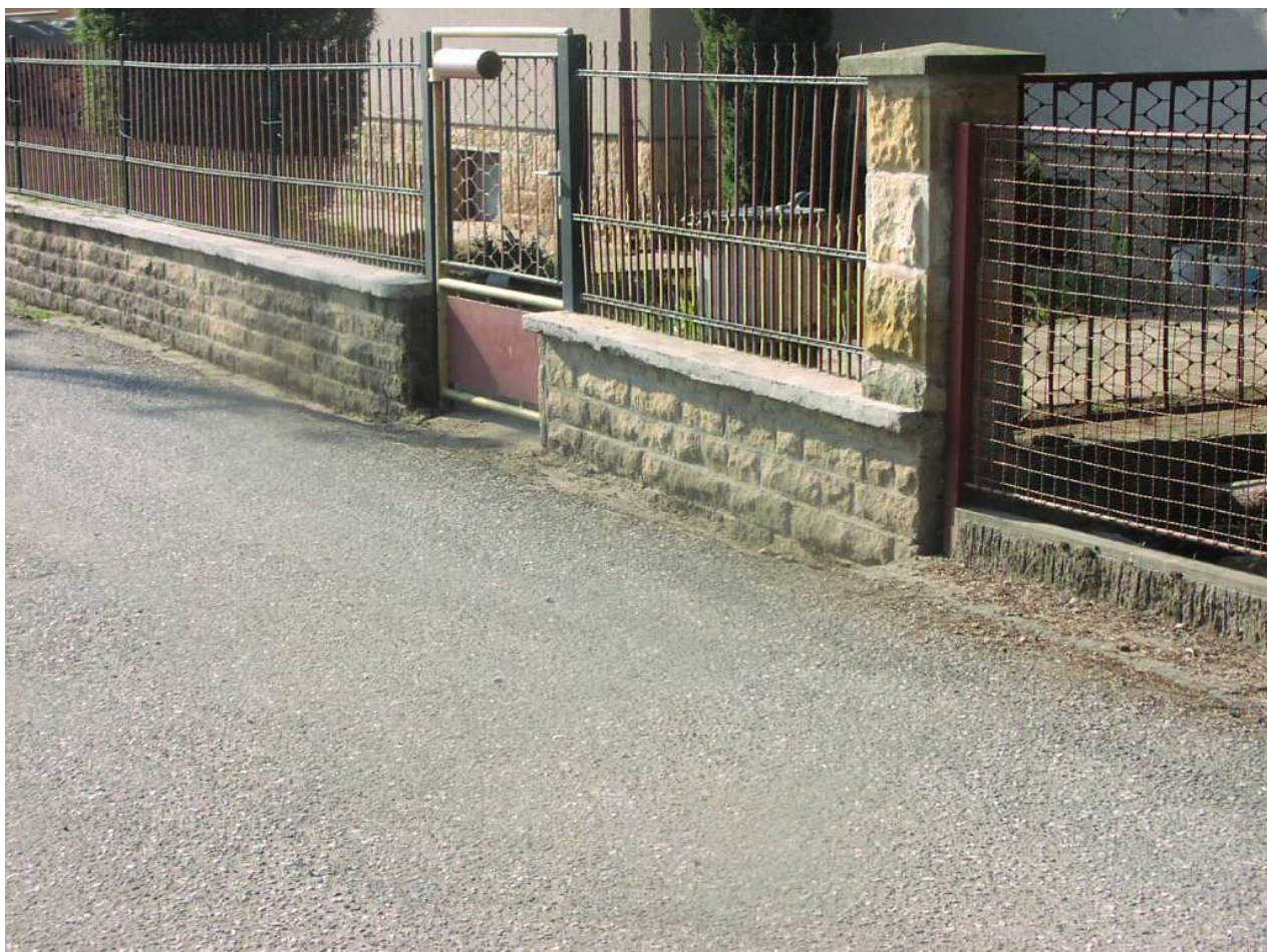
Obr. 2: Asfaltová vozovka bez bezpečnostního odstupu (neupravovaný úsek),
