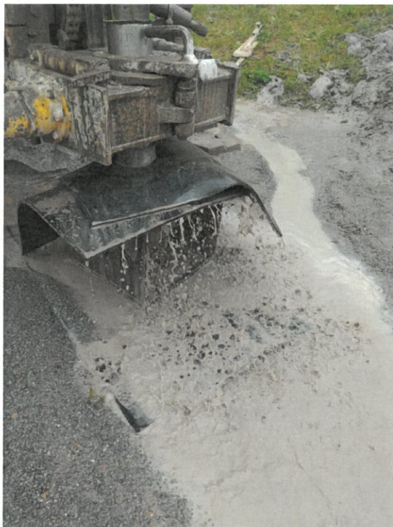
Foto 1 – Hloubení průzkumného hydrogeologického vrtu PI-1-21
