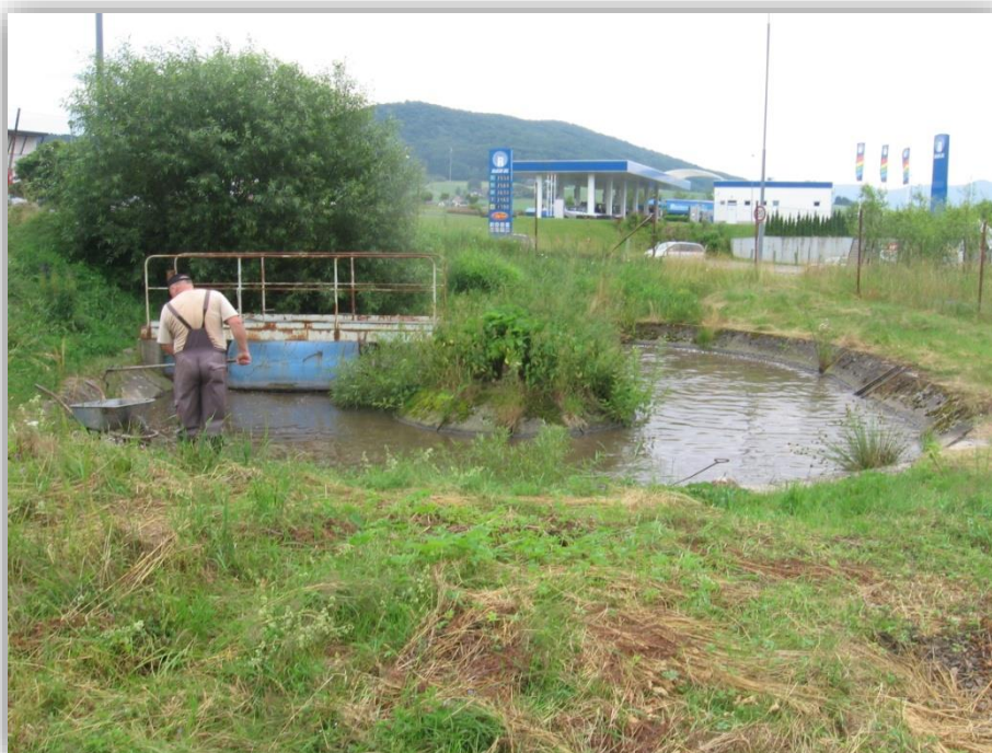
Oxidační příkop s česlemi a hřebenovým bubnem
