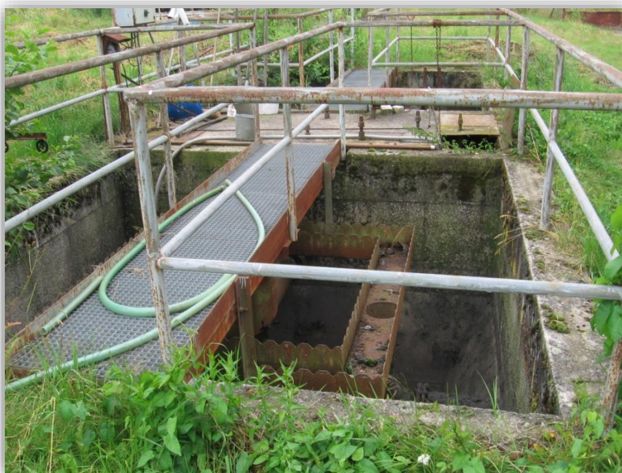
Dosazovací nádrže s kalovou zahušťovací jímkou
